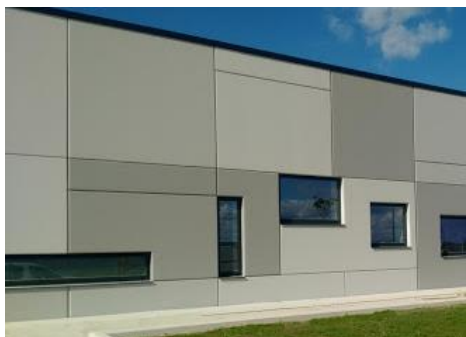
Juntas verticales entre prefabricados de hormigón
