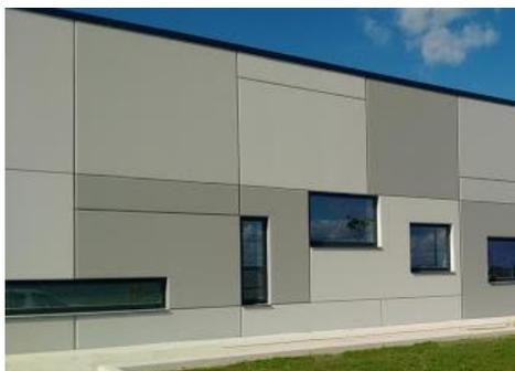
Juntas verticais entre pré-fabricados de cimento
