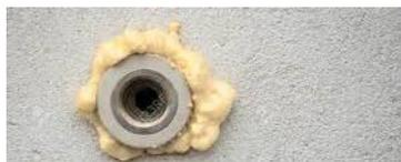
PENOSIL Espuma Multiuso PU-46m utiliza-se especialmente para preenchimento de orifícios e buracos, instalação de caixilharias de janelas e portas, e para a vedação de juntas.
